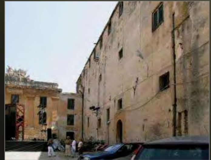
l'edificio prima del restauro
